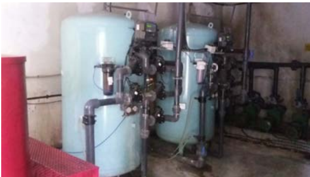
Εικόνα 10: Τριτοβάθμια επεξεργασία στον ΣΕΛ Αγρού (μεμβράνες)
