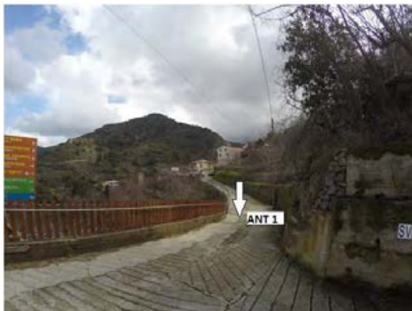
Εικόνα 156: Θέση αντλιοστασίου ανύψωσης λυμάτων, ANT 1
