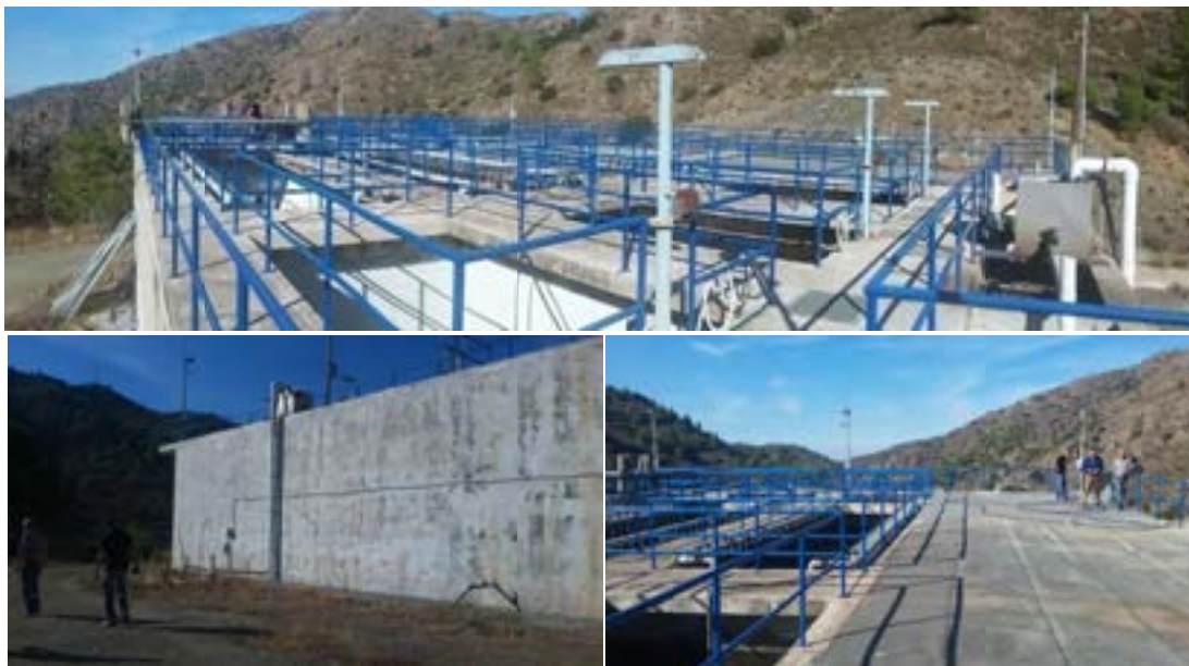
Εικόνα 15: Σταθμός επεξεργασίας λυμάτων στο Παλαιχώρι
