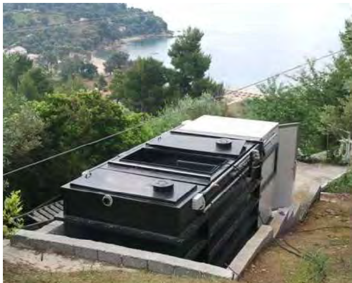
Εικόνα 40: Παράδειγμα compact συστήματος MBR 31
