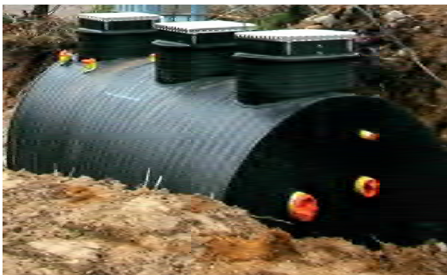
Εικόνα 39: Παράδειγμα compact συστήματος SBR 30
