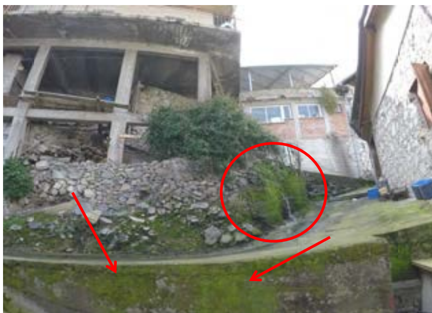
Εικόνα 149: Πρόβλημα υπερχειλίσεων απορροφητικών λάκκων Κοινότητας Μουτουλλά
