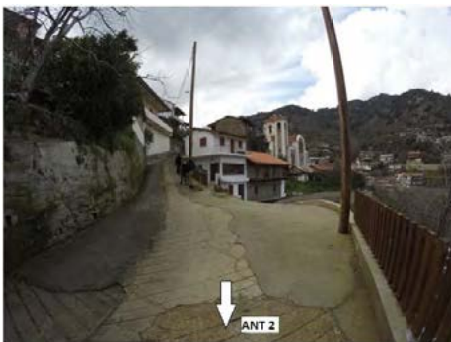
Εικόνα 157: Θέση αντλιοστασίου ανύψωσης λυμάτων, ANT 2
