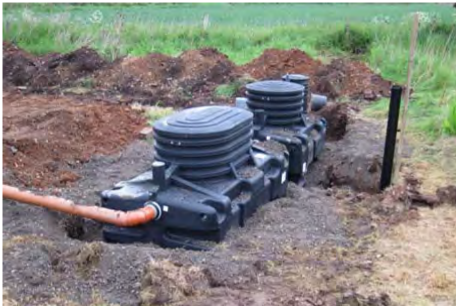
Εικόνα 37: Παράδειγμα compact συστήματος βιομάζας 29
