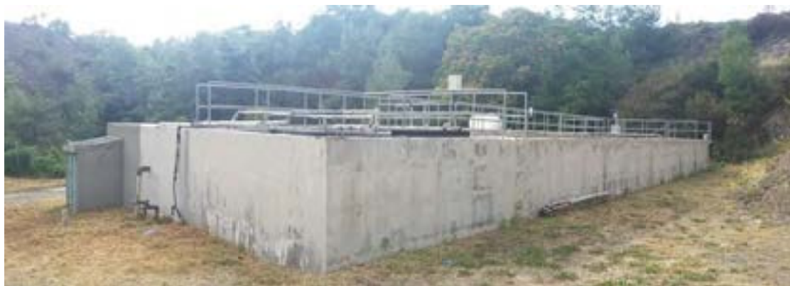
Εικόνα 12: Σταθμός επεξεργασίας λυμάτων στις Πάνω Πλάτρες
